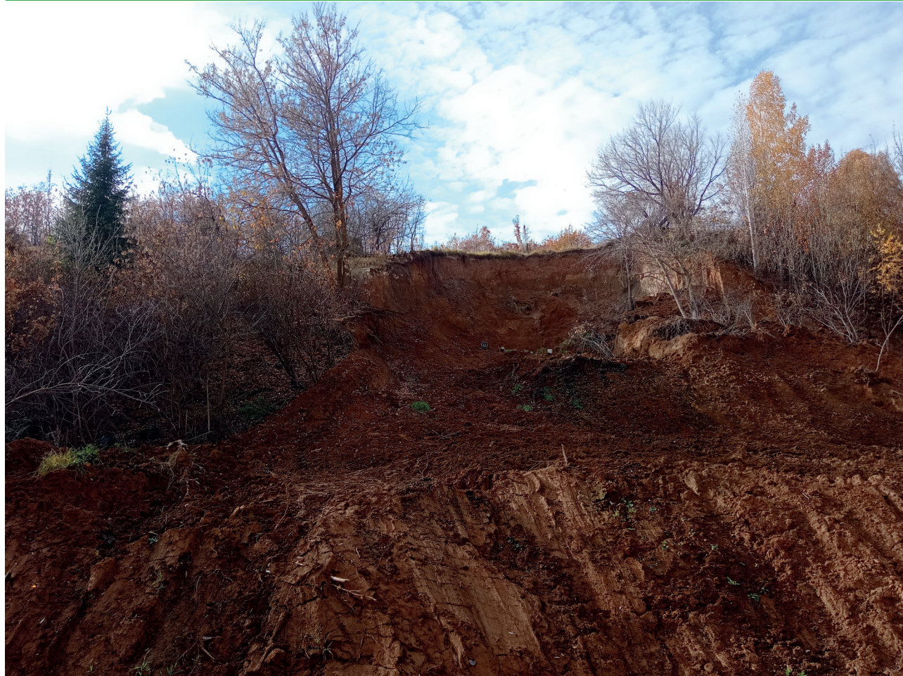
Рис. 16.8.14 Тело оползня, сложенное лессовидными суглинками, фото ноябрь 2021 г.
