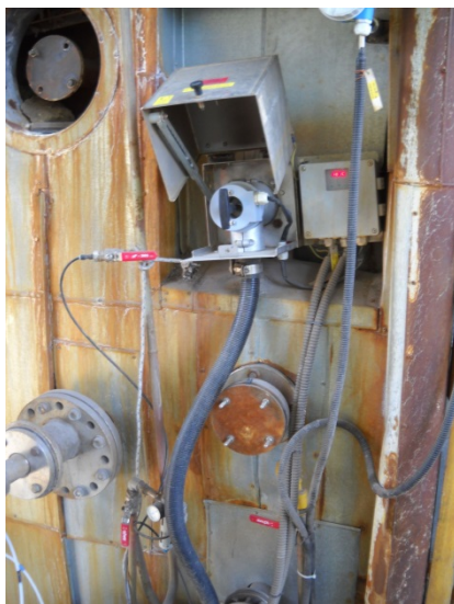
Рис. 3. Пробоотборный зонд и обогреваемая линия.
