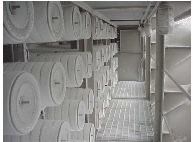
Рис. 4. Обмерзание фильтров.
