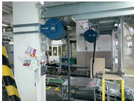
Рис. 5. Посты ручной пылеуборки с катушками для вакуумных шлангов.
