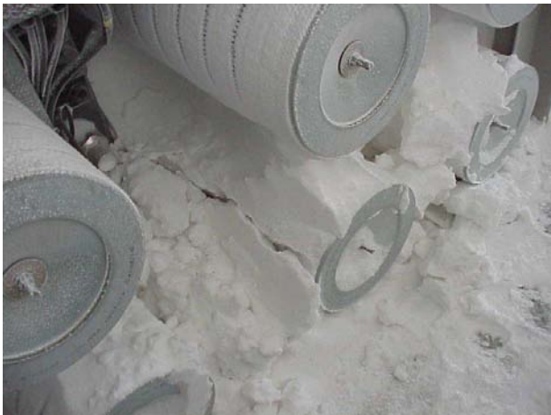
Рис. 3. Забивание фильтров снегом.
