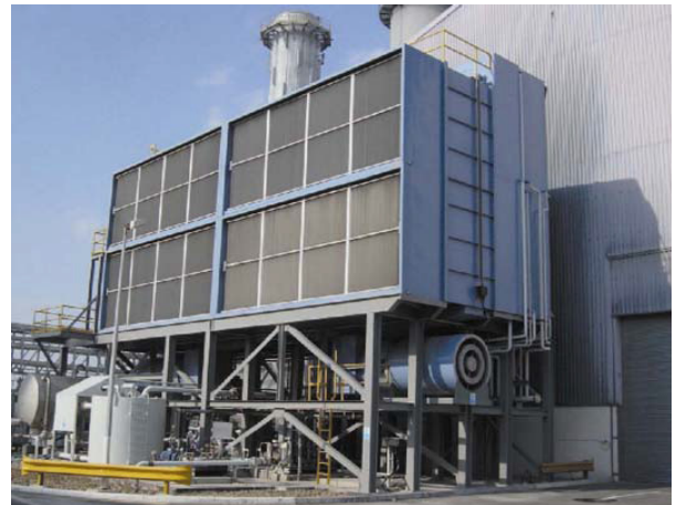
Рис. 6. Воздухозаборные жалюзи-влажнотделители (импульсное КВОУ с самоочищающимися фильтрами ASC AAF).
