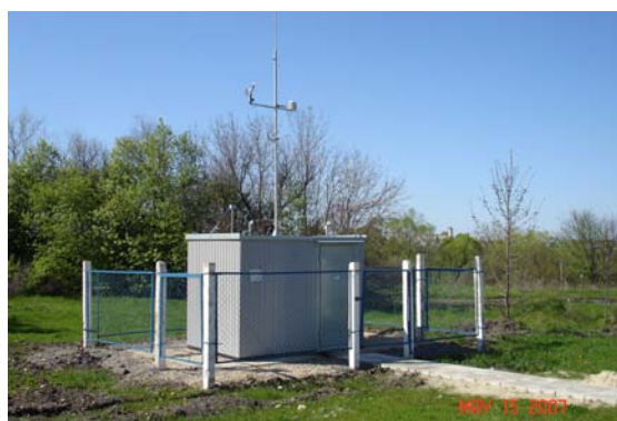
Рис.11 Стационарный пост контроля атмосферы
