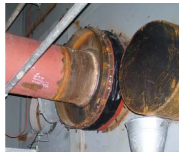
уплотнения прохода коллекторов через обшивку котла
